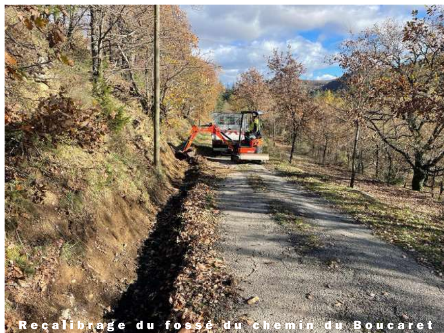
Terrassement préparatoire au bétonnage de la buse de la goutte
