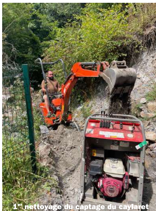
Terrassement préparatoire au bétonnage de la buse de la goutte
